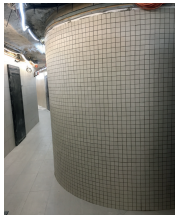
> Tour Z avant travaux
