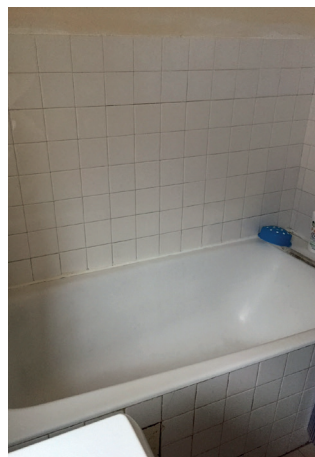
> Gabriel Péri - avant travaux
