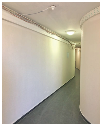
> Tour Z pendant travaux
