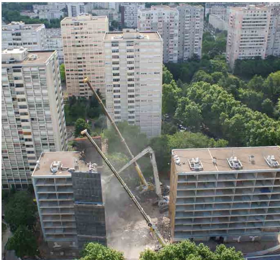
> Démolition du 35 rue Michelet
