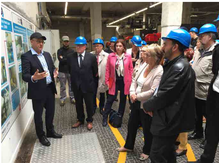
> Présentation de la nouvelle chaufferie du 45 rue Michelet : plus performante et plus économique
