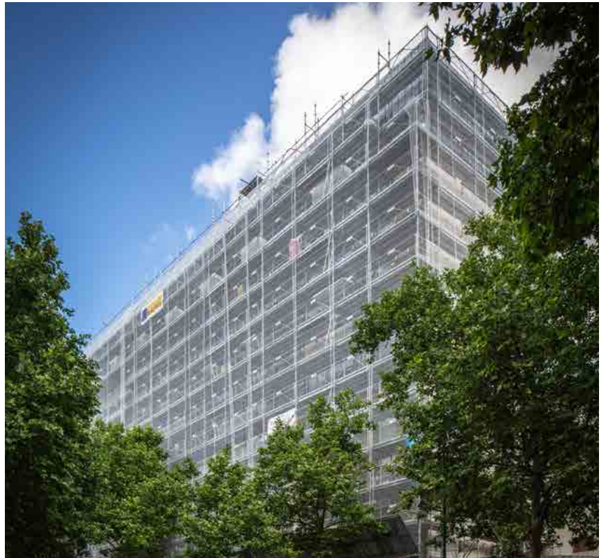
> Réhabilitation du 1, 3, 7 rue Bournard
