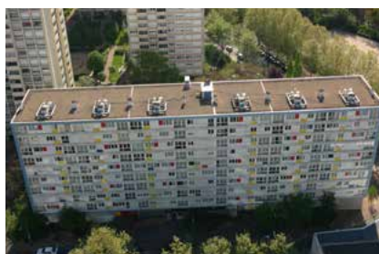
> Immeuble avant confinement
