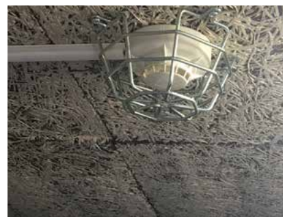
> Local vide-ordures au 3 rue J. Prévert
