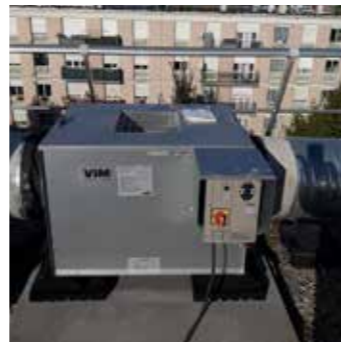
> Remplacement des caissons de VMC 78/84 Kennedy
