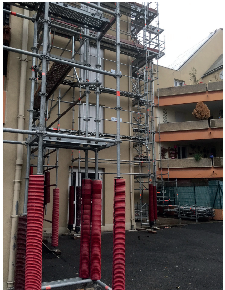
> Réfection des toitures de la résidence Valmy Finlande Kennedy
