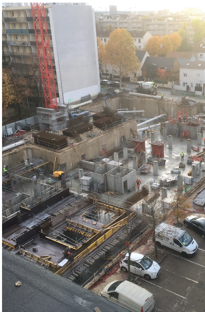
> Chantier 46 rue de l'Egalité
